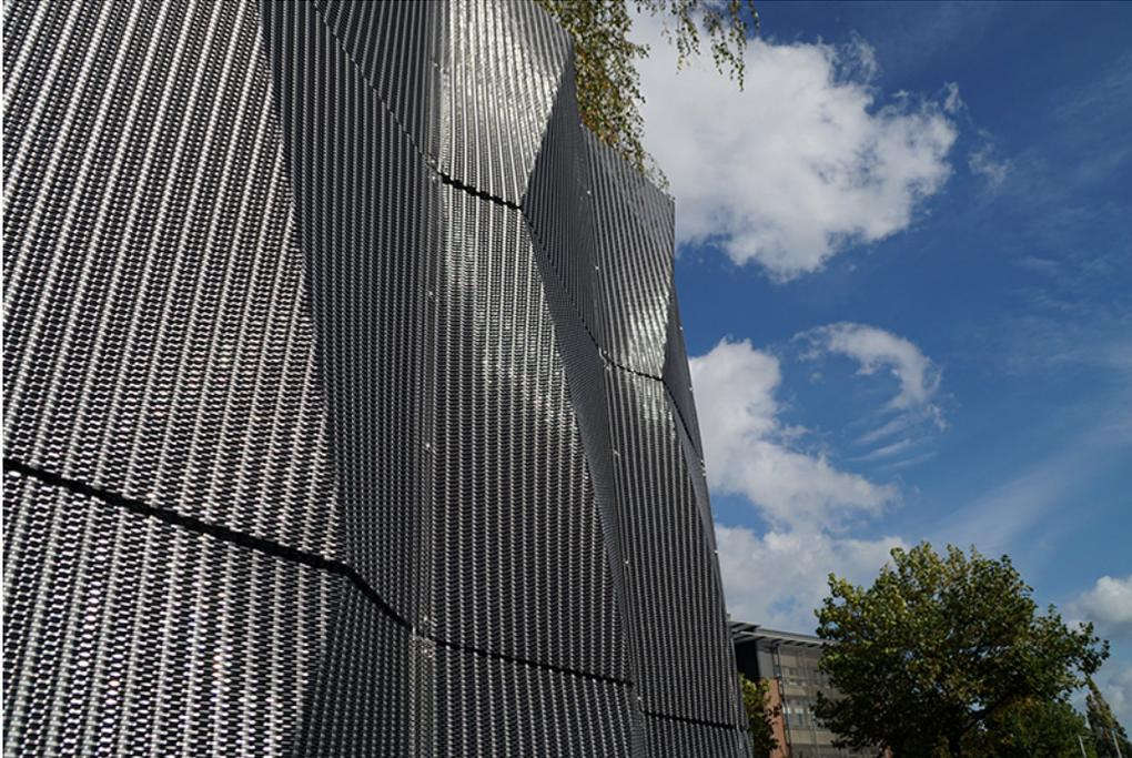
Dreidimensionale Gewebefassade 3D-Fassadensystem aus Edelstahlgewebe.
